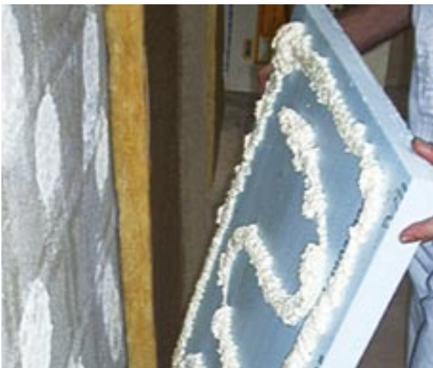
INSTA-STIK aangebracht op isolatieplaat voor verticale bevestiging
