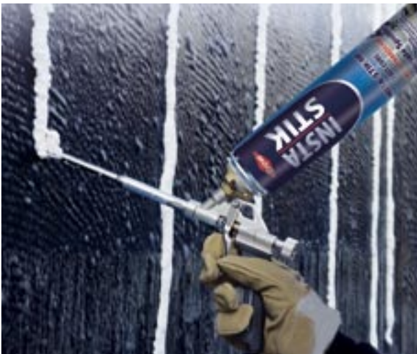
Aanbrengen van INSTA-STIK MP met spuitpistool op verticale wand
