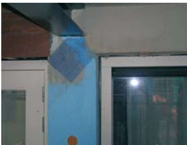
Buitengevelisolatiesysteem Extreme Therm met tegelafwerking
