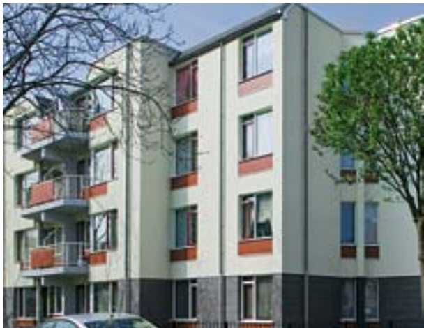
Buitengevelisolatie uitgevoerd met pleisterwerk en tegels
