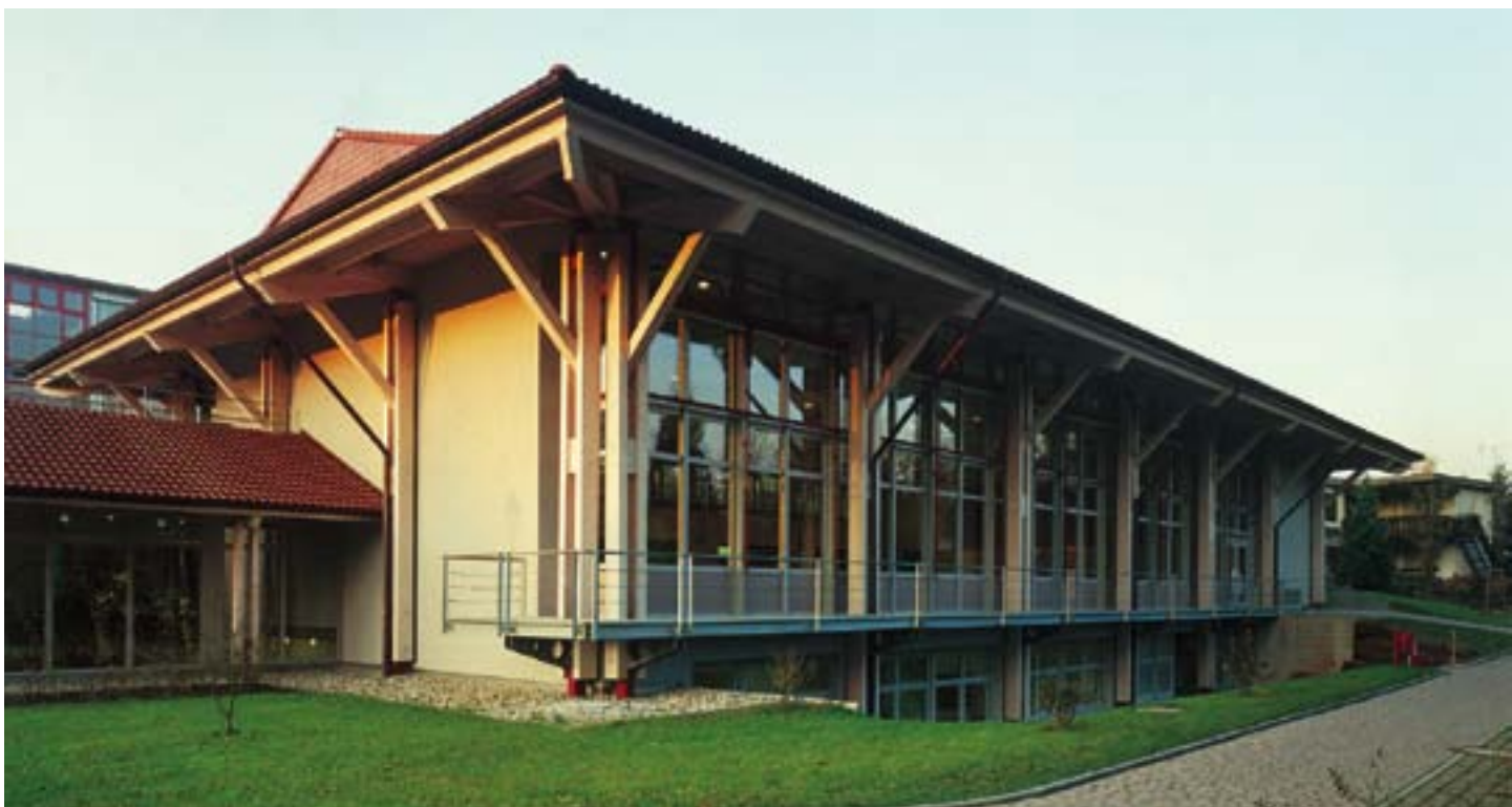
Kelderisolatie toegepast aan buitenzijde verwarmde ruimte
