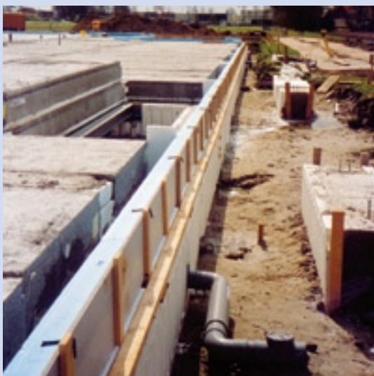
Styrock toegepast als verloren bekisting
