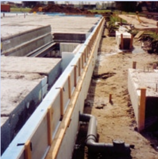
Styrorock toegepast als verloren bekisting
