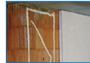
Gebruik van INSTA-STIK MP met isolatieplaat op steenachtige ondergrond
